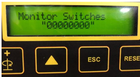
Kontrolle der Schalter
