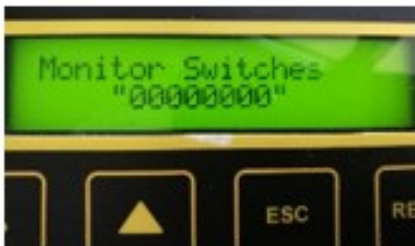
Kontrolle der Schalter
